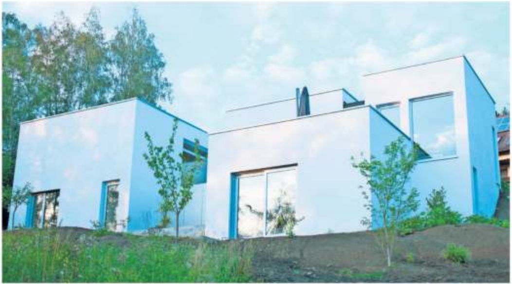
Das Haus von Bauherr und Architekt Christoph Faltenbacher wird am kommenden Dienstag im BR vorgestellt. Foto: Sebastian Faltenbacher
